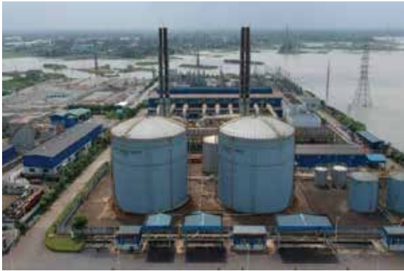
(Kodda 150MW Power Plant)
